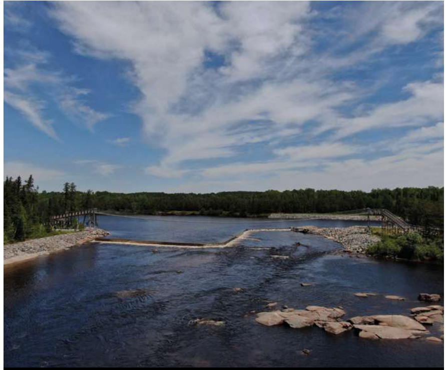
Les MRC Maria-Chapdelaine et Domaine-du-Roy et le Conseil des Montagnais opèrent la minicentrale de 18,3 MW de la 11 e Chute située sur la rivière Mistassini, à Notre-Dame-de-Lorette.
