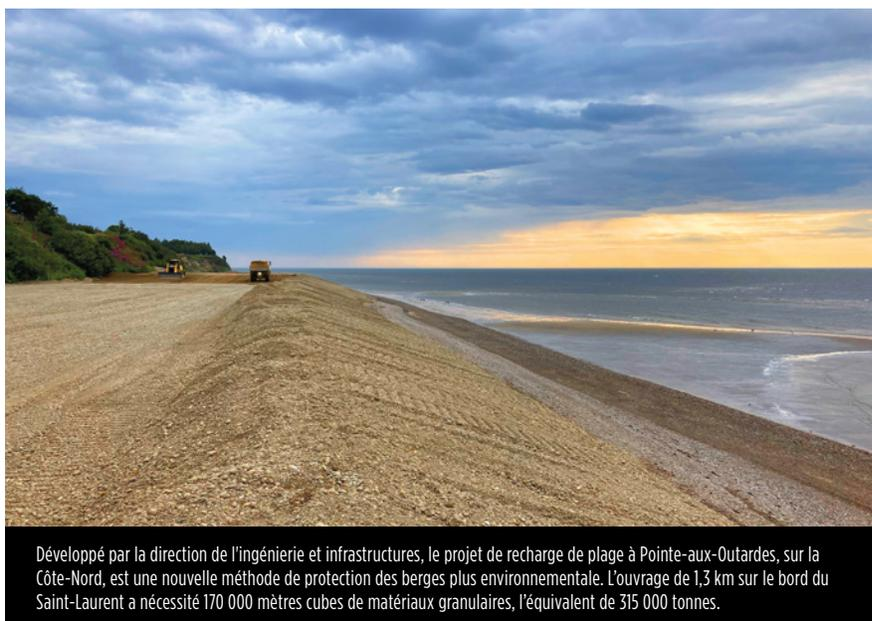
Développé par la direction de l'ingénierie et infrastructures, le projet de recharge de plage à Pointe-aux-Outardes, sur la Côte-Nord, est une nouvelle méthode de protection des berges plus environnementale. L'ouvrage de 1,3 km sur le bord du Saint-Laurent a nécessité 170 000 mètres cubes de matériaux granulaires, l'équivalent de 315 000 tonnes.
